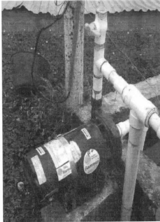
**Foto. Motobomba instalada al lado de los filtros dinámicos para el lavado de la PTAP.**
