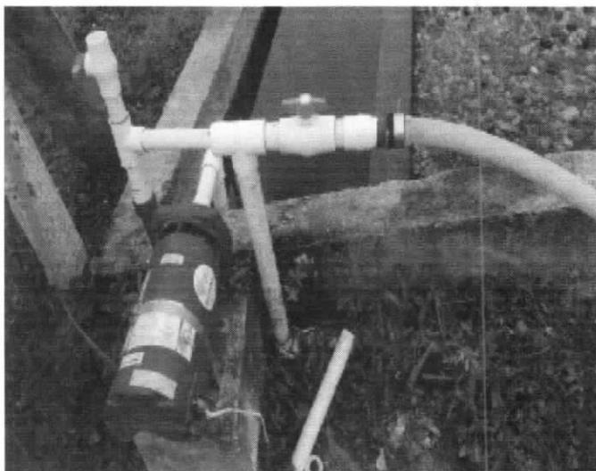
**Foto. Motobomba instalada al lado de los filtros dinámicos para el lavado de la PTAP.**
